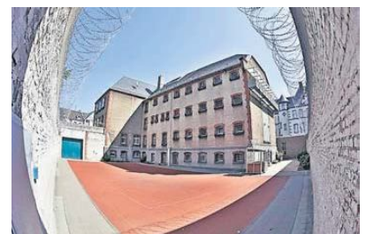
Im Gefängnis am Nordwall werden Gewahrsamszellen eingerichtet.
